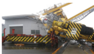
平成30年9月台風21号での 大阪港の被害状況
